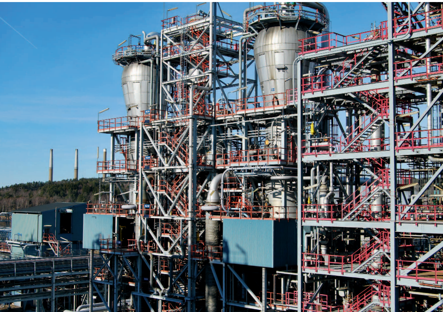
Den sista av de tre reaktorena i polyetentillverkningen, gasfasreaktorn. Här tillverkas ett femtontal olika produkter. Därför gäller det att optimera omställningarna.
